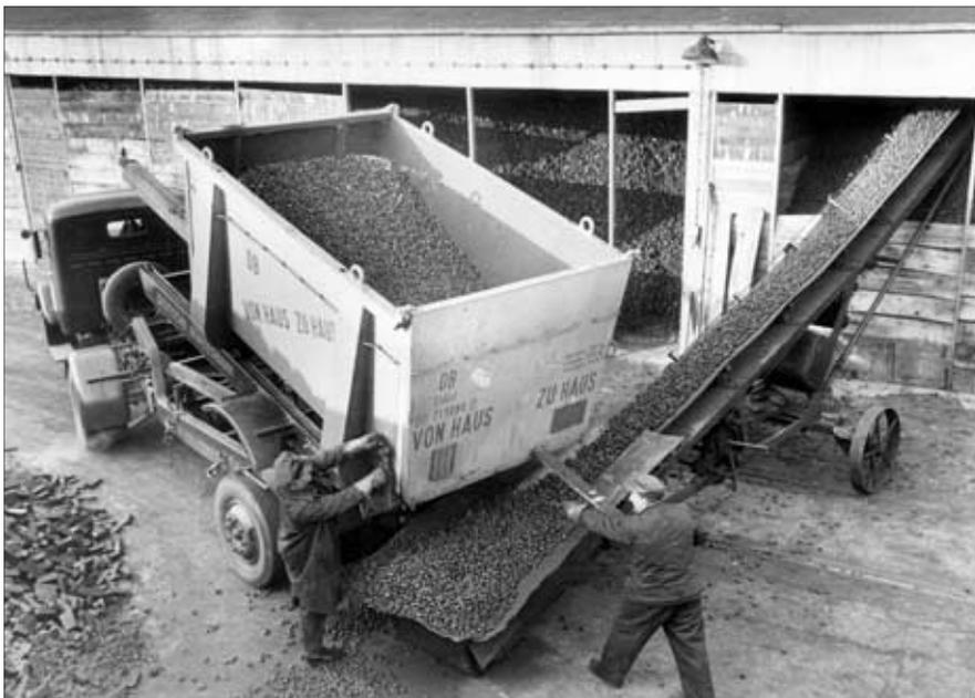
Behälter und Tragwagen in allen Variationen: Noch mit DR-Zonen-Beschriftungen präsentiert sich der 599 615 auf einer DB-Ausstellung im Hauptgüterbahnhof Frankfurt/M am 1.5.1954. Links wird die Belieferung eines Kohlelagers mittels Eokrt-Behälters und Förderband gezeigt, unten ein Dzkr-Behälter für losen Zement nebst Druckluftaggregat. Fotos: H. Oesterling/Archiv Michael Meinhold
