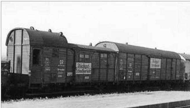
Bei der ersten Bauform des Leig aus dem Jahre 1927 verwendete man neben dem gedeckten Güterwagen GI noch einen Güterzugpackwagen (Pwg) der einstigen preußischen Staatsbahn.
