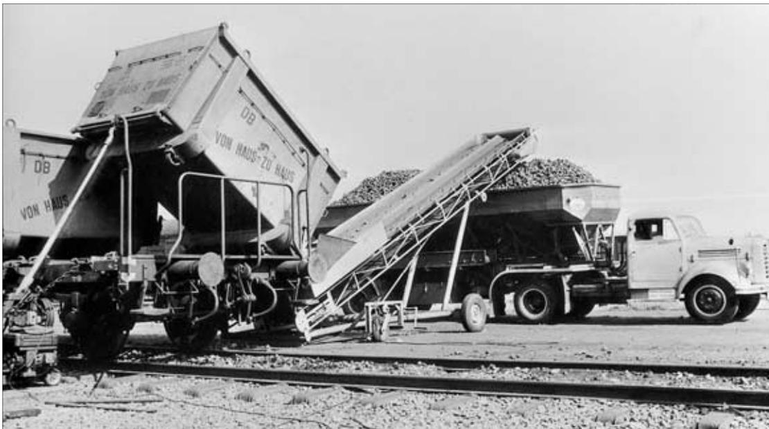
Umladen von Brennstoffen aus einem Eokrt-Behälter über Breitförderband in den Lkw. Man beachte den Hubantrieb und die Kettensicherung gegen das Umkippen des Tragwagens.
