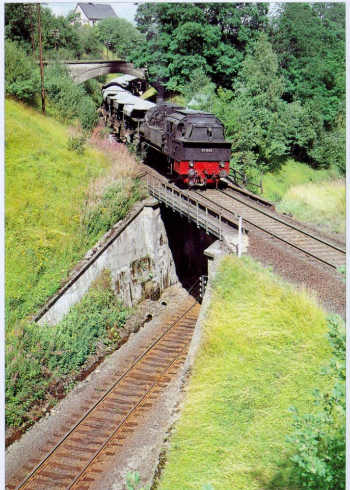
Überführung bei Erbach; Baumgruppe tarnt obere Strecke
