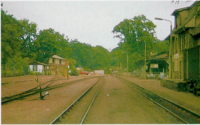
▲ Die Gleisanlagen des Bahnhofs Göhren auf Rügen sind auch heute noch recht umfangreich, auch wenn der Güterverkehr seit 1968 ruht.
