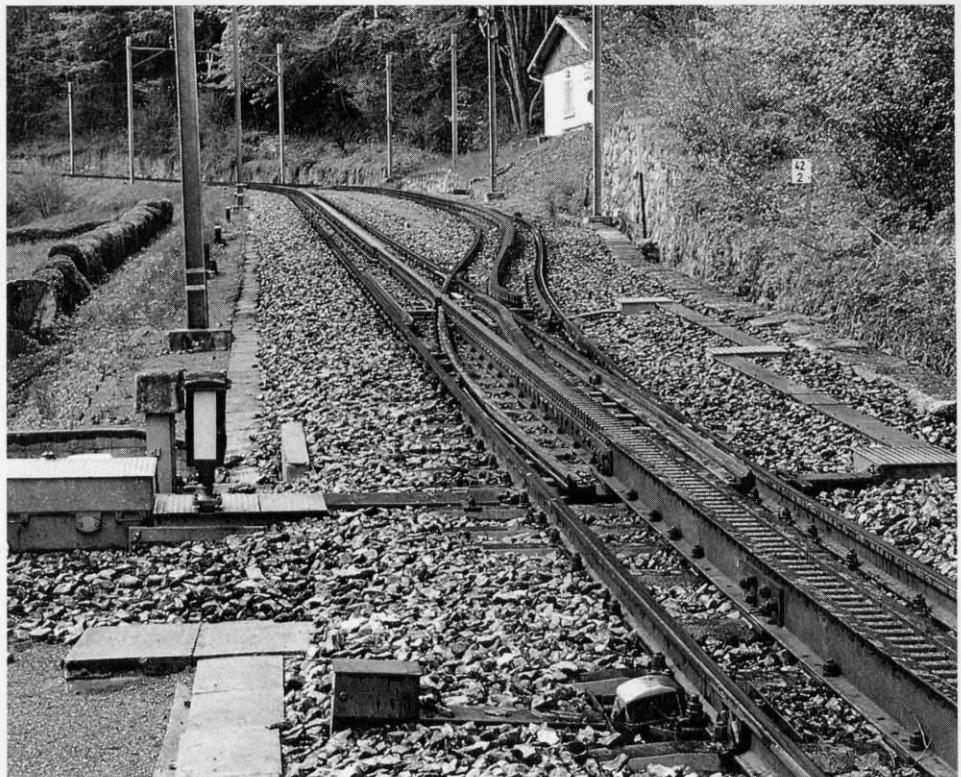
Blick in Richtung Brünig. Deutlich sichtbar die Steigung. Beim Riggenbach-System ist die Zahnstange im Zungenbereich starr, im Bereich der Innenschienen legt sie sich jeweils über die Innenschiene. Bei anderen Systemen ist die Zahnstange im Bereich der Zungen und Innenschienen mit den beweglichen Schienen gekoppelt, und schiebt sich jeweils in Gleismitte.
