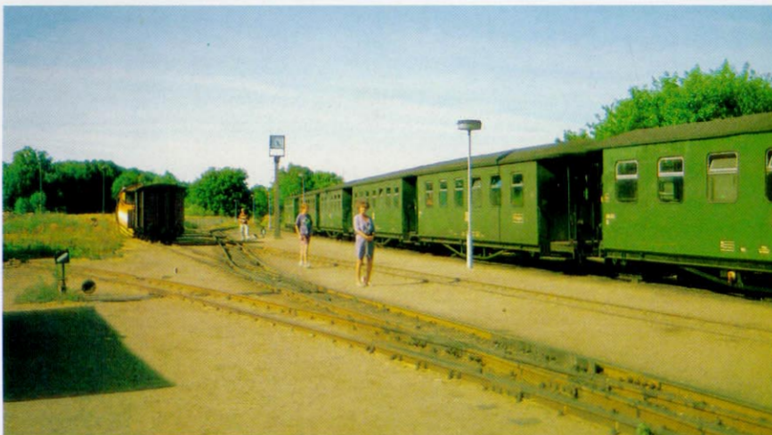
▲ Die Gleisanlagen im Schmalspurteil des Bahnhofs Putbus in Richtung Göhren. Das Abstellgleis links mit den Güterwagen ist die ehemalige Ausfahrt nach Altefähr, das Gleis im Vordergrund führt zur Überladerampe.
