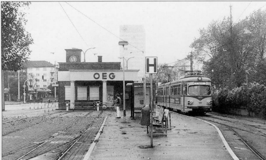
▲ Das kleine Empfangsgebäude der OEG am Endbahnhof in Mannheim-Kurpfalzbrücke. Der Triebwagen 99 steht am Ausstiegsgleis.
