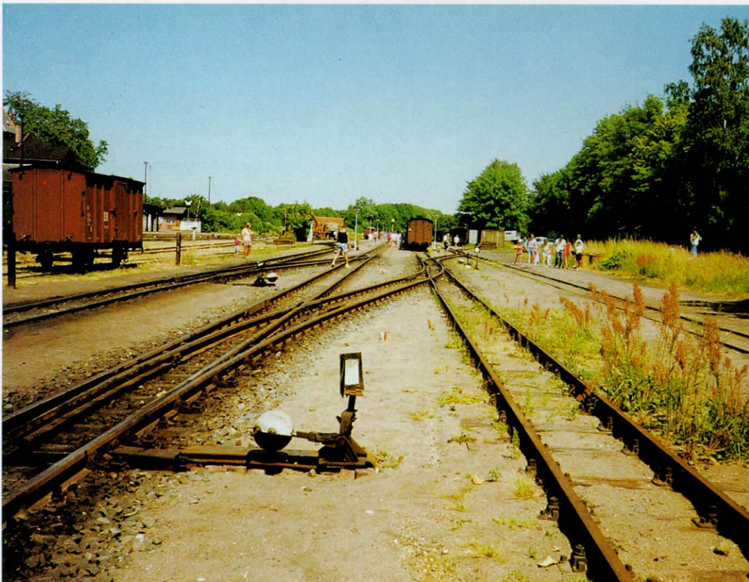
◀ Ebenfalls im Bahnhof Putbus entstand diese Aufnahme. Sie zeigt die Gleisanlagen vom Bw aus gesehen in Richtung Göhren. Typisch für viele Schmalspurbahnen: Die Schwellen der Gleise sind fast vollständig mit Sand bedeckt, nur die Weichen liegen frei. Alle Fotos: Ulrich Rockelmann
