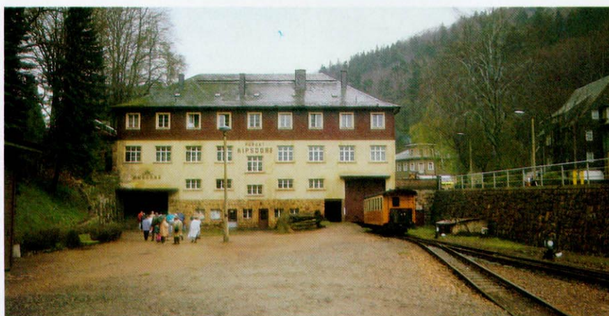
◀ Das Empfangsgebäude des Bahnhofs Kurort Kipsdorf steht in Kopflage zu den Gleisen. Das Gleis rechts führt zu der Laderampe innerhalb des Gebäudes.
