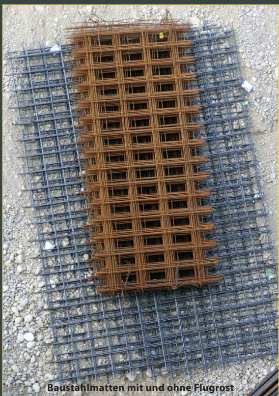
Lagerplatz mit Baustahlmatten
